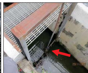
รูปที่ 13 ประตูกั้นน้ำมัน (Oil trap gate) และระบบป้องกันน้ำท่วม ในกรณีฉุกเฉิน
