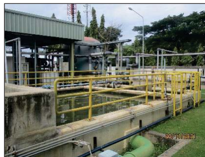
รูปที่ 15 บ่อบำบัดน้ำสุดท้าย (Final check basin)
