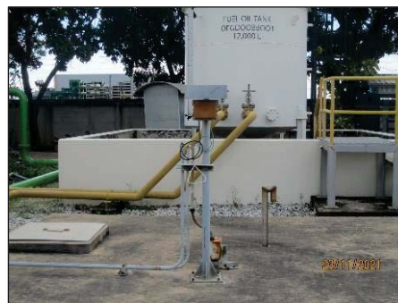
รูปที่ 10 Oil Separator และ Oil Alarm
